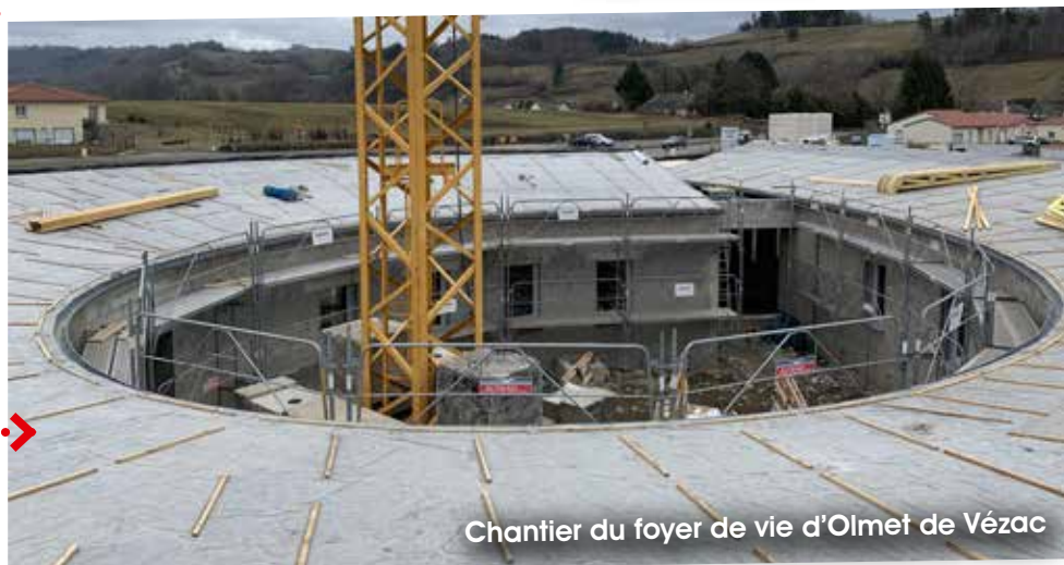
Chantier du foyer de vie de Boisset
