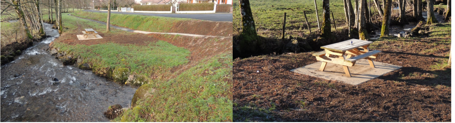
Mise en place d'une table de pique-nique au pont de Barathe.
