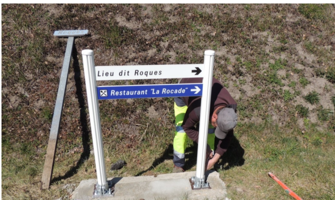
Pose d'un panneau signalétique à Roques.
