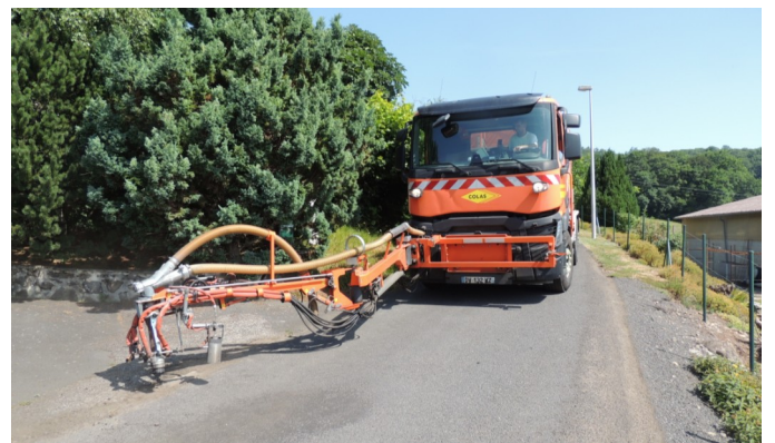
Comme les années précédentes trois jours de point à temps pour la reprise de la chaussée sur l'ensemble de la commune.
