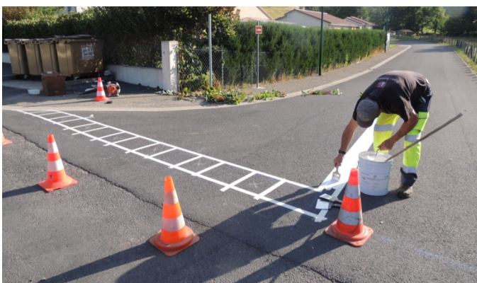
Pour des raisons de sécurité et à la demande des riverains, un cédez le passage a été mis en place à la sortie du lotissement les Méjanes.
