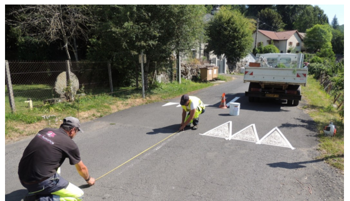
Reprise de la peinture à Roques.
